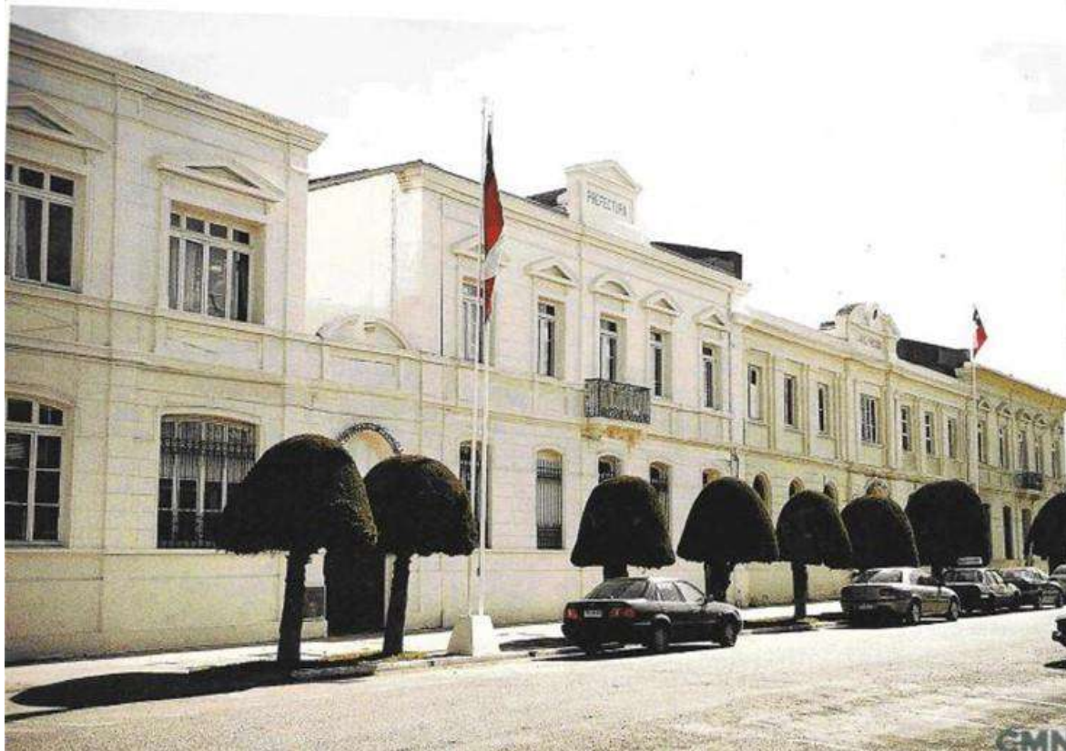
Fotografía N°19: Prefectura de Carabineros de Punta Arenas, Edificio fue declarado Monumento Histórico en el año 2009
